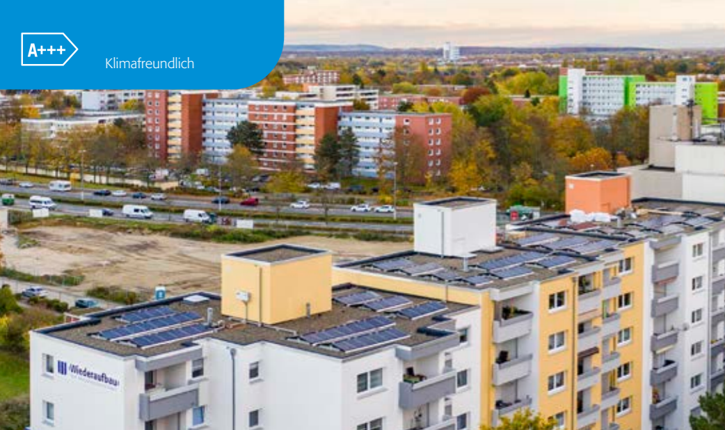
Auf den Hausdächern im Glanweg wurden auf einer Fläche von rund 211 Quadratmetern 130 Module einer Photovoltaik-Anlage installiert.
