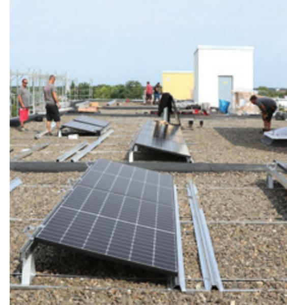
Die Photovoltaikanlage besteht aus insgesamt 130 Modulen, die einzeln auf dem Dach montiert wurden.
