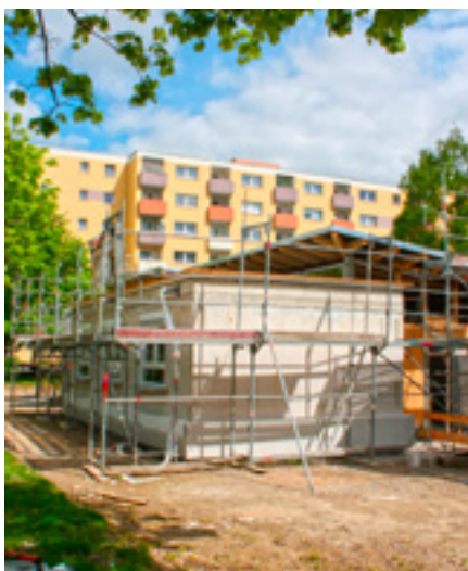
Der Rohbau ist fertig. Nun wird innen fleißig weiter ausgebaut.
